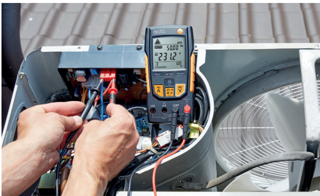
Măsurarea tensiunii pe o unitate de refrigerare exterioră cu testo 760 .
