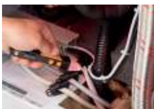
Verificare preliminară pe un compresor
