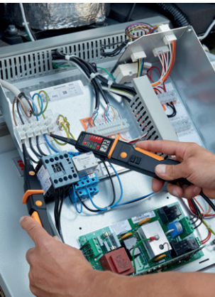
Măsurarea tensiunii pe un compresor.
