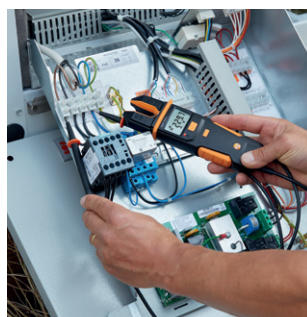
Măsurarea tensiunii pe un compresor.
