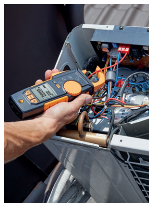
Prinderea cablului cu cleștele ampermetric într-o unitate de refrigerare exterioară
