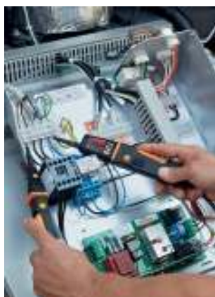
Măsurarea tensiunii pe un compresor.
