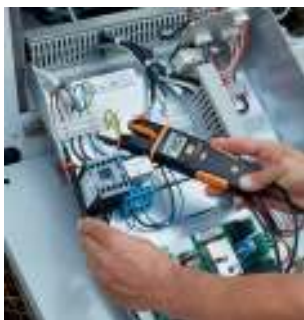
Măsurarea tensiunii pe un compresor.
