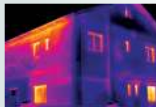
Detectarea pierderilor de căldură din clădiri: identificarea rapidă și înregistrarea punțiilor termice și a izolațiilor defectuase.
